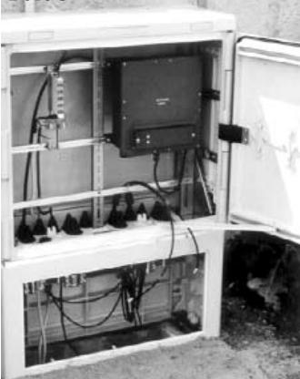
в инженерном ограждении при его преодолении. Деформация кабеля или его смещение, а также общая вибрация заграждения являются основой превышения установленного в датчике порога и как результат факта перехода последнего в режим «Тревога».
